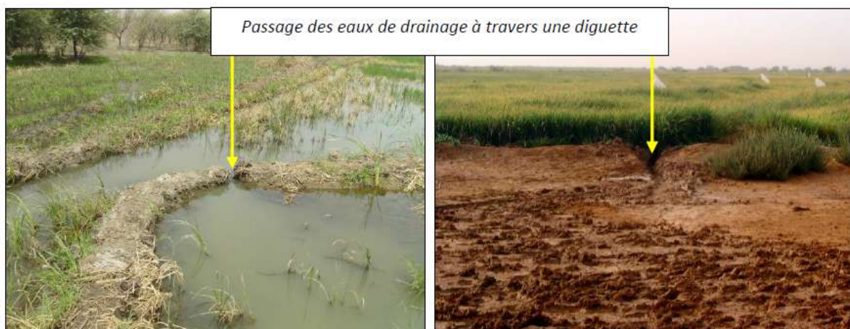
PHOTO 6.5 – Méthodes de drainage des PIP
