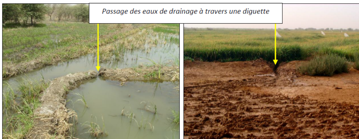
PHOTO 6.5 – Méthodes de drainage des PIP
